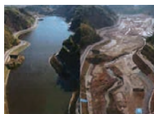
施行前・竣工後写真の比較や 工事の定期定点写真に
